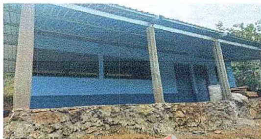
Foto 4: INSTALACION DE COSTANERAS DE METAL
