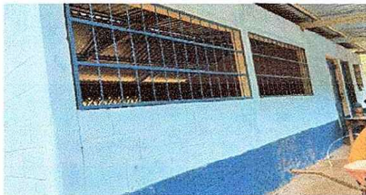
Foto1: INSTALACIONES DE BALCONES DE METAL
