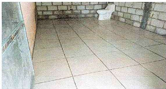
Foto 3: SUSTITUCION DE ISO CONCRETO POR PISO CERAMICA
