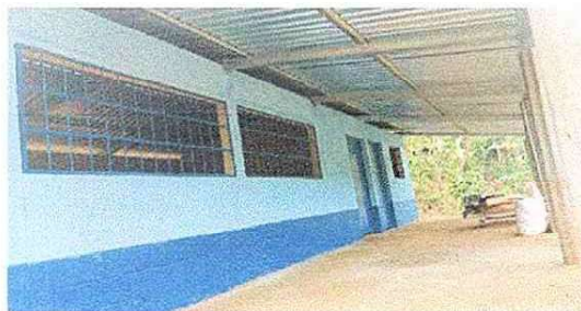
Foto 2: MANTENIMIENTO DE CORREDOR DE CONCRETO A PISO
